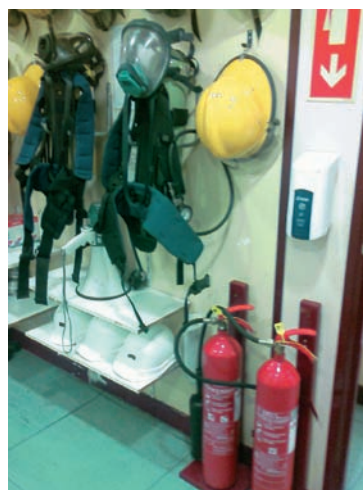
Figura 35 Equipamentos de segurança da equipa de intervenção/extintores portáteis. Fonte: Centro Comercial Colombo. Lisboa, 2009.
